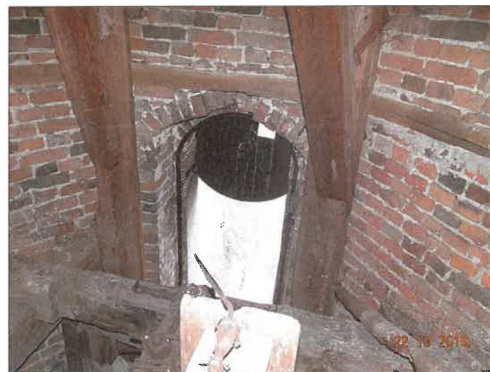
widok uszkodzonego nadproża jednego z okien na poziomie dzwonnicy (okna 02)
