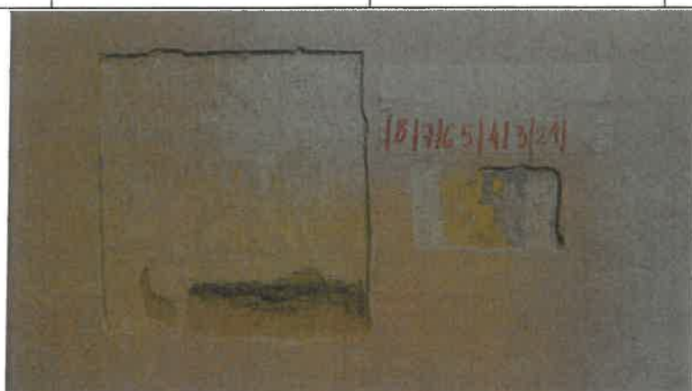
Fot. 17. Sonda schodkowa na południowej ścianie zakrystii. Zidentyfikowano wtórne XIX-wieczne tynki.
