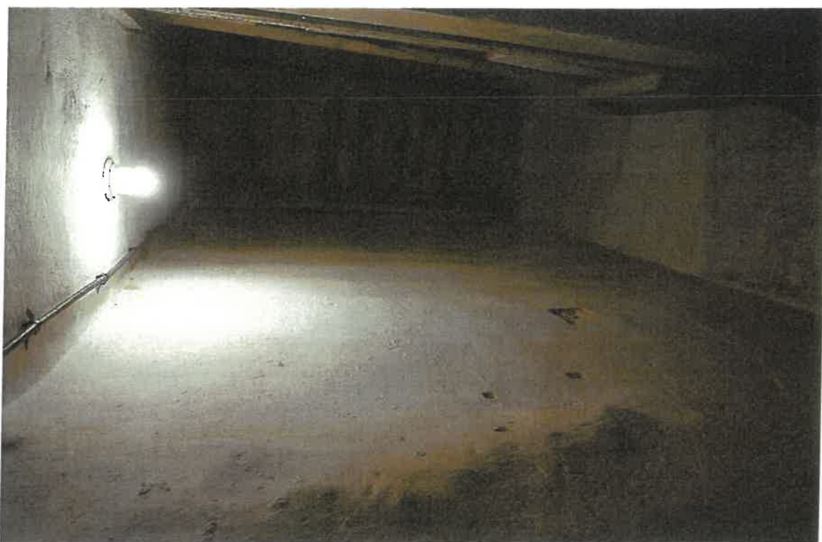
Fot. 4. Parter wieży. Na ścianach widoczne zachowane pierwotne wyprawy tynkarskie eksponujące naturalną krzywiznę muru.
