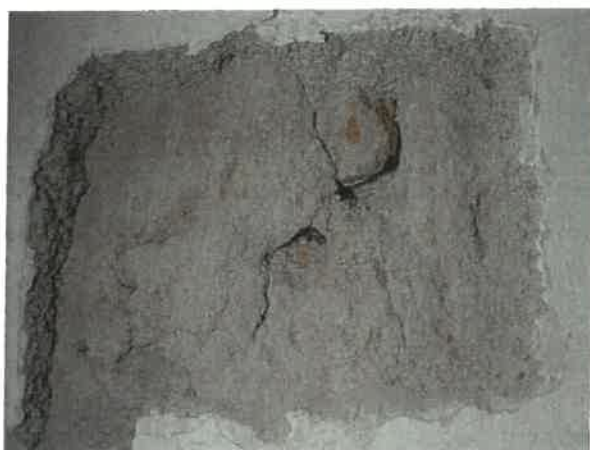
Fot. 17 i 18. Widoczna odkrywka płaszczyznowa i sonda pasowa na ścianach wewnętrznych wieży (parter). Ściany wieży posiadają 2 warstwy tynków, pierwszy bardzo nieregularny z jasno-ceglastym wykończeniem. Drugi gruboziarnisty, który z czasem był bielony.
