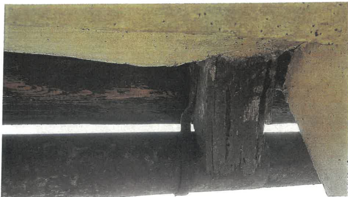
Zdj. 36- korkiew dachu wieży przy rynnie – widoczna działalność owada.
