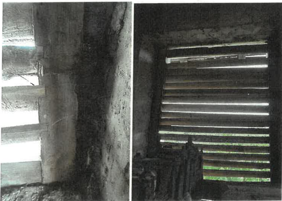
Fot. 29 i 30. Żaluzje okienne powojenne z drewna iglastego, pokryte warstwą zabezpieczającą drewno.
