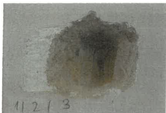
Fot. 8. Odkrywka na wschodniej ścianie prezbiterium. Brak pierwotnych wypraw tynkarskich. Na murze znajduje się bezpośrednio współczesny tynk wapienno-piaskowy z dodatkiem cementu.
