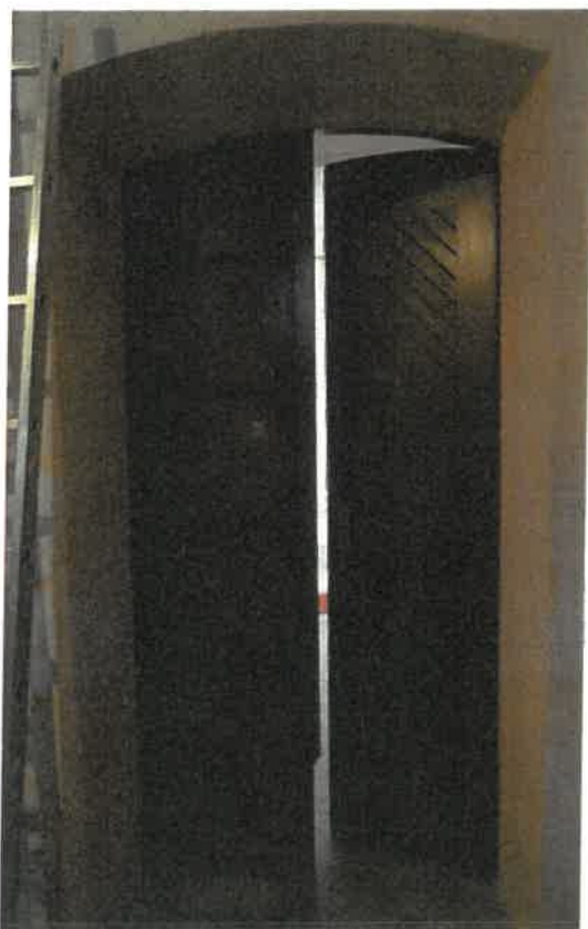
Fot. 35 i 36. Na drzwiach znajdują się wtórne powłoki olejne. Drzwi prawdopodobnie były pokostowane lub usunięto pierwotne kryjące warstwy malarskie.
