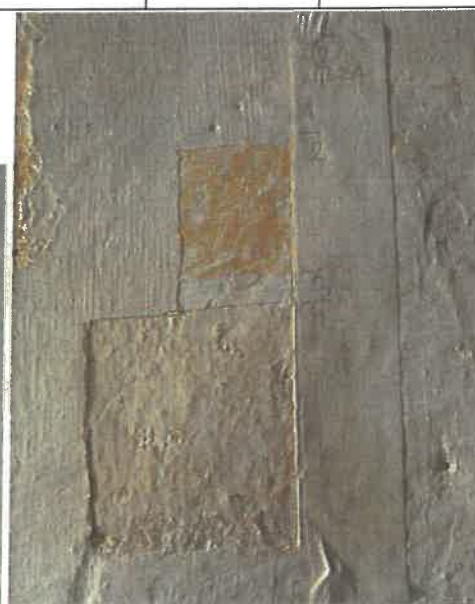
Fot. 17 i 18. Widoczna odkrywka płaszczyznowa i sonda pasowa na ścianach wewnętrznych wieży (parter). Ściany wieży posiadają 2 warstwy tynków, pierwszy bardzo nieregularny z jasno-ceglastym wykończeniem. Drugi gruboziarnisty, który z czasem był bielony.
