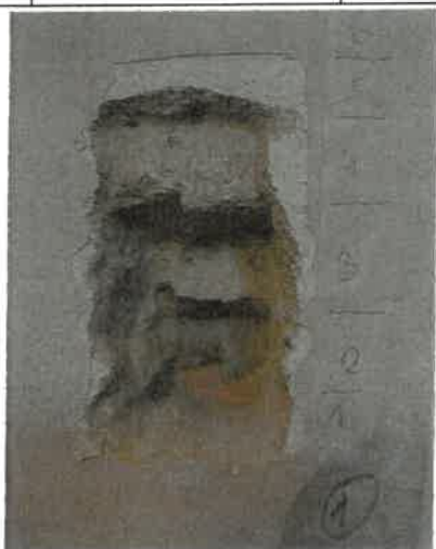
Fot. 9 i 10. Odkrywki w dolnej i górnej części ściany północnej prezbiterium. Na ścianie północnej prezbiterium znajdują się wtórne narzuty. Nie zidentyfikowano pierwotnych gotyckich wypraw.
