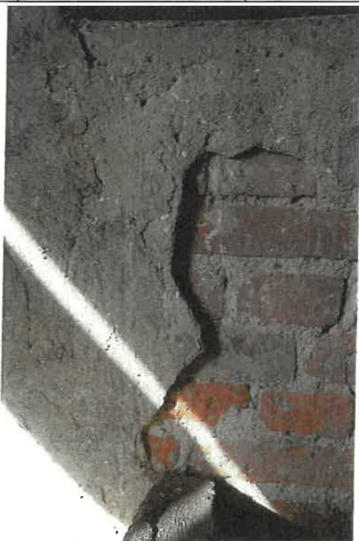
Fot. 19. Naturalna odkrywka na trzeciej kondygnacji wieży. Widoczny mur ceglany spoinowany zaprawą wapienno-piaskową, obrzucony gruboziarnistym tynkiem wapienno-piaskowym. Wymalowanie tynku nie zachowało się. Po wojnie na ściany wieży położono przecierkę wapienno-piaskową z dodatkiem cementu i pomalowano w białym kolorze.
