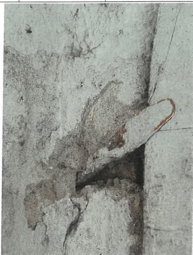
Fot. 18. Naturalna odkrywka pierwotnych warstw technologicznych XIX-wiecznej wieży. Widoczny janougrowy kolor w ościeżu wieży.
