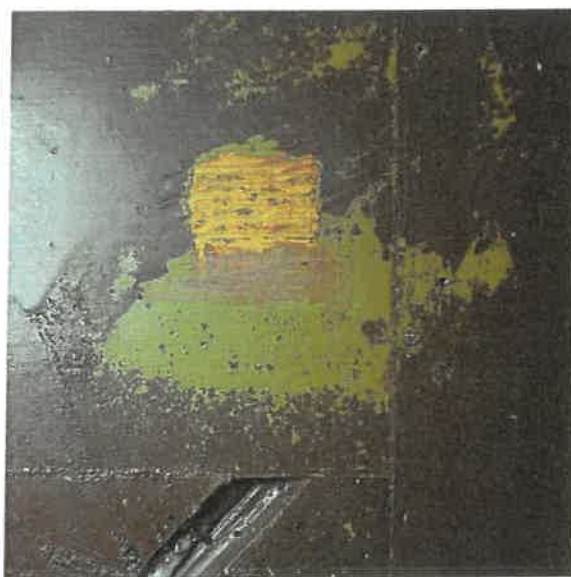
Fot. 35 i 36. Na drzwiach znajdują się wtórne powłoki olejne. Drzwi prawdopodobnie były pokostowane lub usunięto pierwotne kryjące warstwy malarskie.
