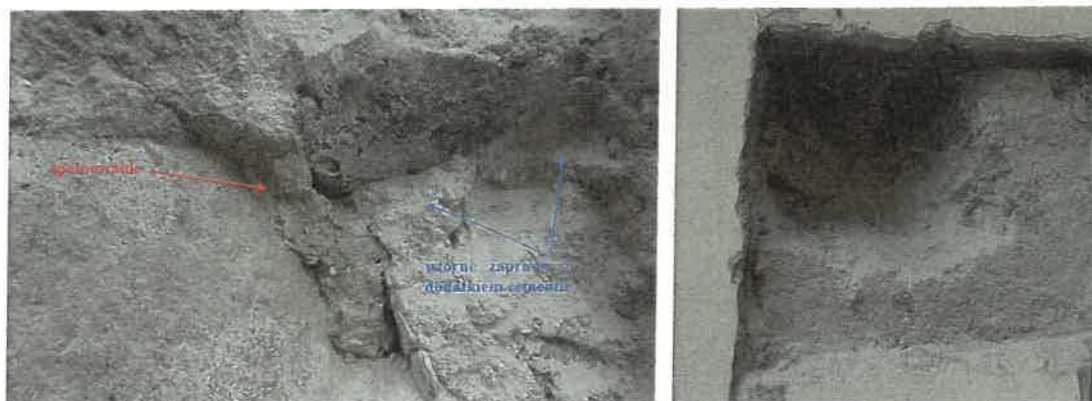
Fot. 23. Na cokole kościoła wykonano oszalowanie i wylewkę betonową a następnie tynki.
