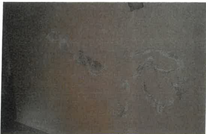
Fot. 3. Widok na dolną część ścian we wnętrzu kościoła filialnego pw. św. Antoniego w Niemstowie. Wzdłuż przyziemia pojawiły się wykwity solne.
