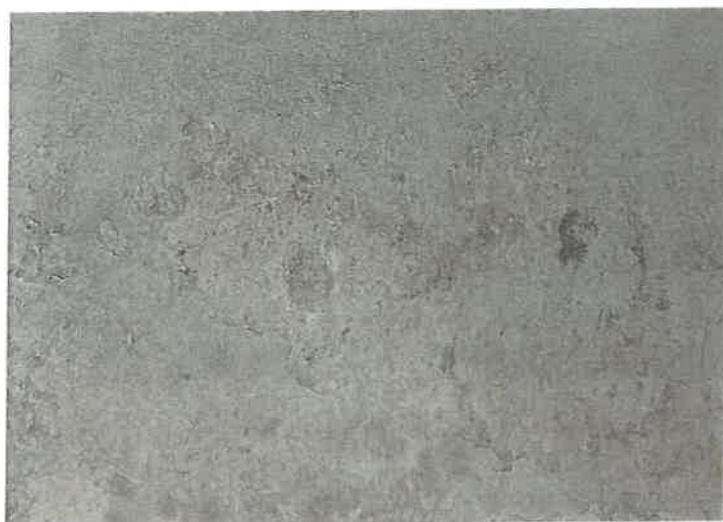
Fot. 16. Odkrywka w niszy sakramentarium. Zidentyfikowano wapienno-piaskową wyprawę i jasno-ugrowy kolor na pobiale.
