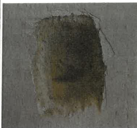
Fot. 9 i 10. Odkrywki w dolnej i górnej części ściany północnej prezbiterium. Na ścianie północnej prezbiterium znajdują się wtórne narzuty. Nie zidentyfikowano pierwotnych gotyckich wypraw.
