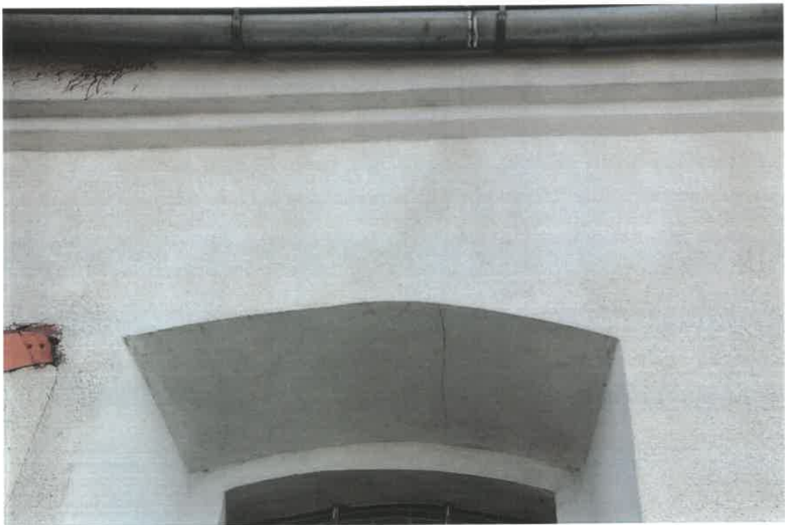
Zdj. 47 – Rysa ok 1mm na nadprożu - elewacja północna
